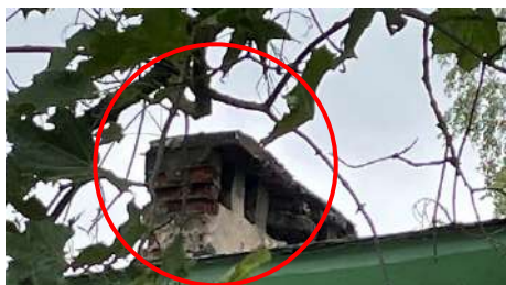
разрушенный оголовок дымовых и вентиляционных каналов
